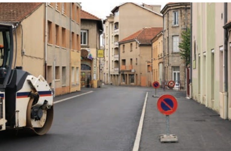
Le revêtement est terminé et le rouleau compresseur vient de terminer le compactage du goudron.
