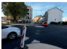
Fin des travaux rue Gambetta
